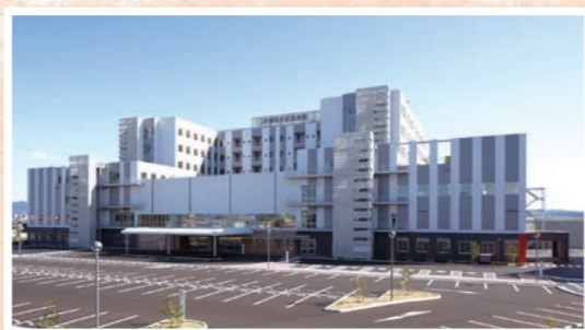
2016(平成28)年 第二岡本総合病院を久御山町佐山へ 新築移転「京都岡本記念病院」と改称
